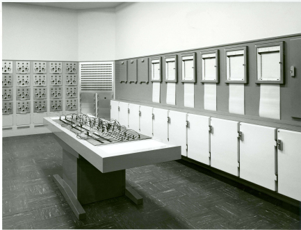
Figuur 5: De Deltar (Delta getij analogon Rekenmachine), de analoge computer die op Van Veen's ‘electrische methode’ is gebaseerd. Aan de tafel op de voorgrond werden de geografische configuraties opgezet.
