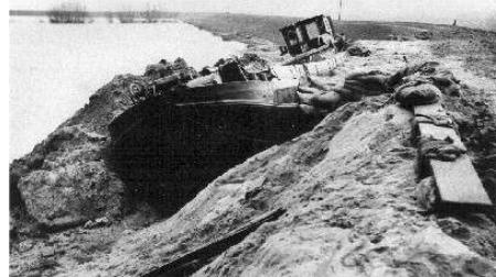
Figuur 4: Het schip waarmee het gat bij Nieuwerkerk is gedicht. (Het water is inmiddels flink gezakt)
